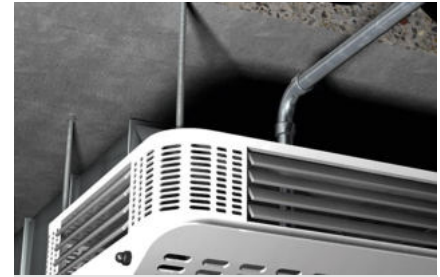
Podwieszenie urządzeń klimatyzacyjnych
