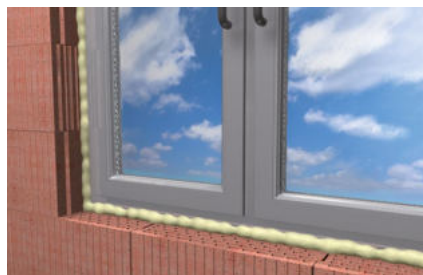
Uszczelnianie ościeżnic okiennych i futryn
