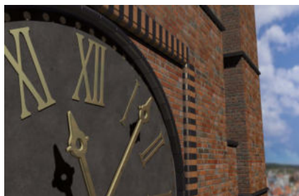
Renowacja ścian osłonowych
