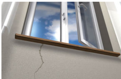
Uszczelnianie rys i pęknięć
