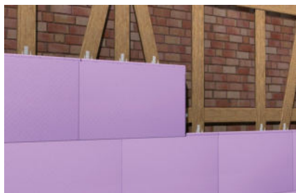
Sztywne płyty izolacyjne na ruszcie drewnianym
