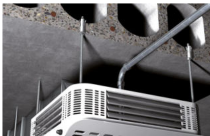
Urządzenia klimatyzacyjne mocowane do płyt kanałowych
